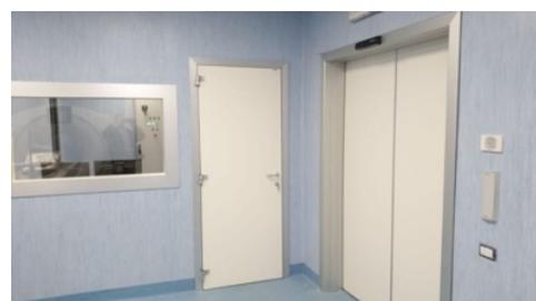
anta costruita in tamburato di legno duro e interposta lamina di piombo di prima fusione, titolo 99,9%, calibrata e spazzolata, rivestimento in laminato Porte Piombate Anti-x scorrevoli con anta/e scorrevoli costruite in legno con interposta lamina di piombo di prima fusione titolo 99,9%, rivestimento in laminato plastico, corredate di struttura di sostegno, binari con carrelli di scorrimento e mantovana sia manuale che automatica.
